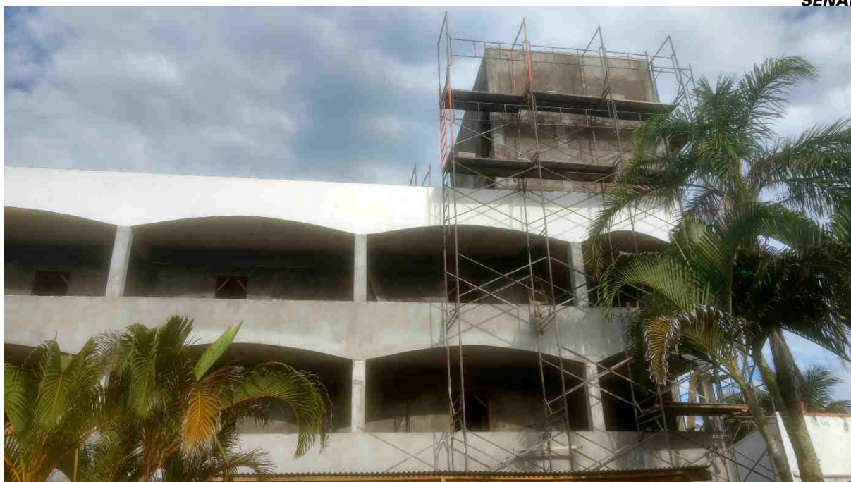
Foto da obra da Colônia de Férias de JUN/2017
