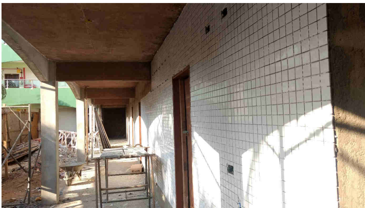
Foto da obra da Colônia de Férias de JUL/2017
