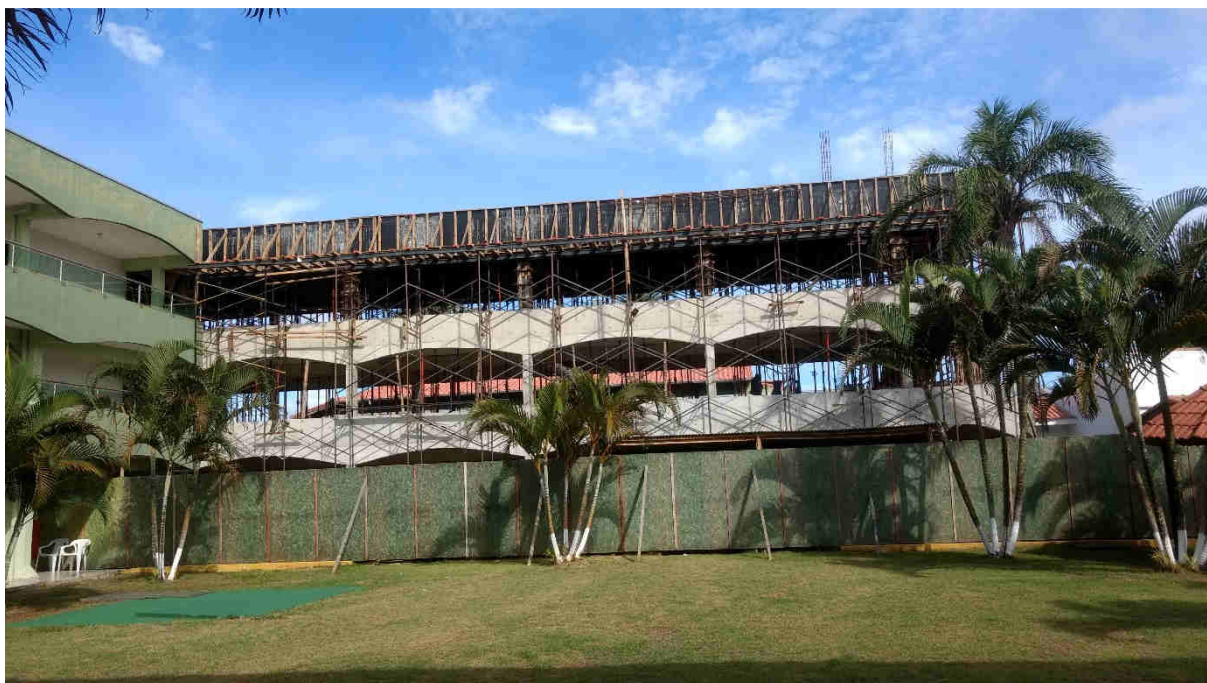
Foto da obra da Colônia de Férias de MAR/2017
