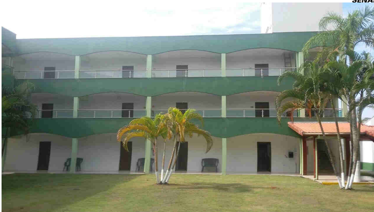
Foto da conclusão das obras da Colônia de Férias
