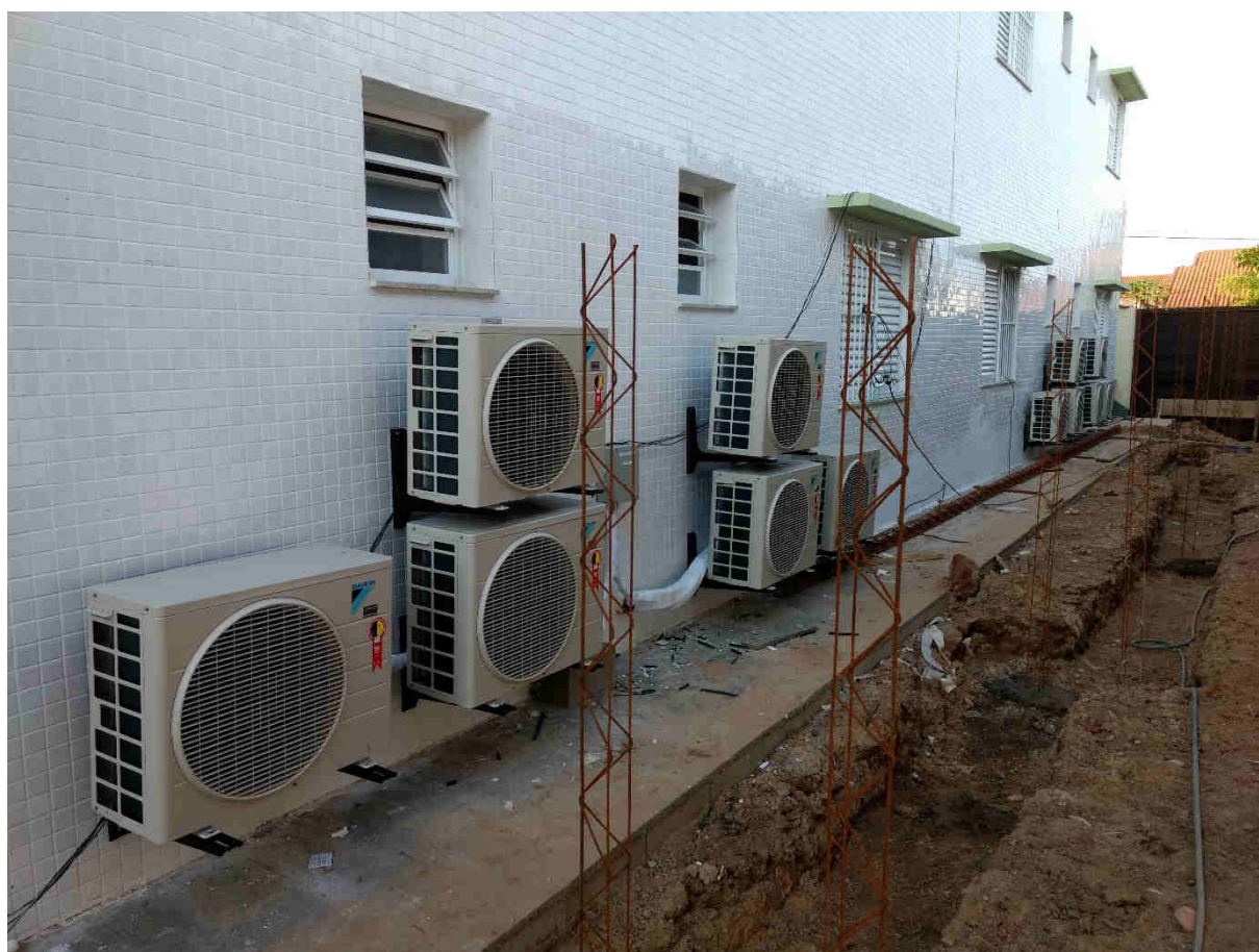
Foto da obra da Colônia de Férias de NOV/2017
